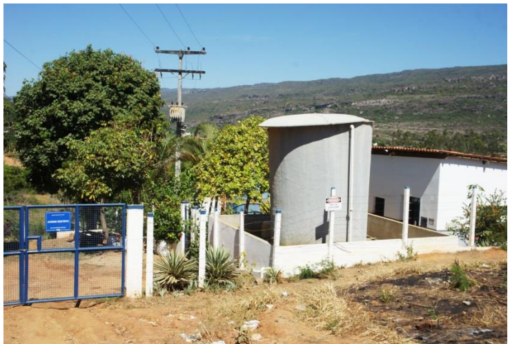
Estação de tratamento em Andaraí: O sistema precisa ser ampliado (Foto: Christoph Hess)
