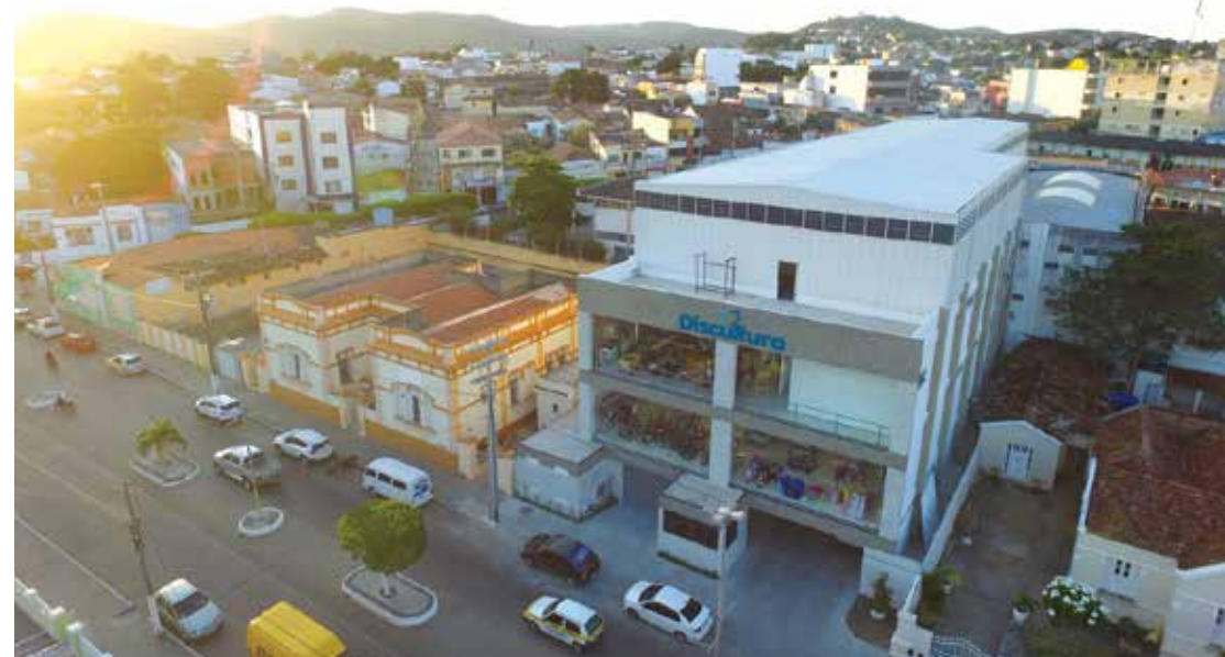
A nova loja dispõe de um estacionamento para 25 vagas com entrada pela Avenida Rio Branco
